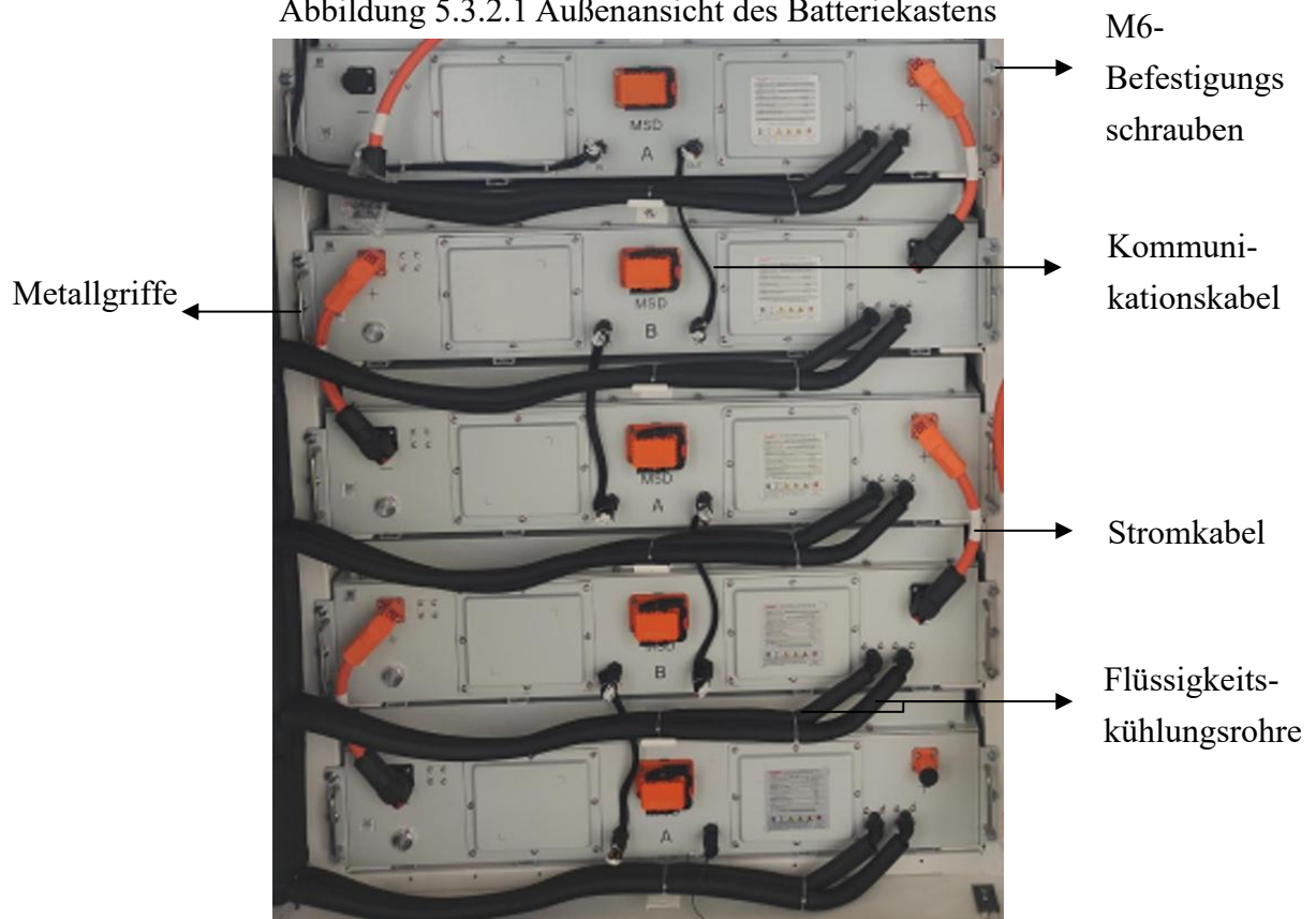
Abbildung 5.3.2.2 Strom- und Kommunikationsanschlüsse des Batteriekastens
